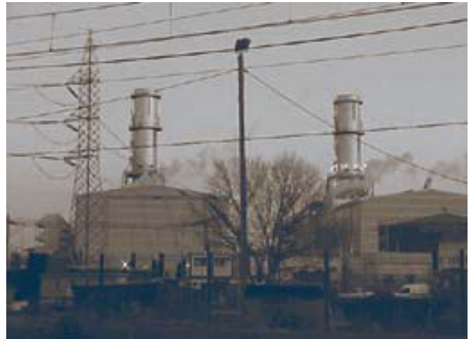
Central tèrmica de ciclo combinado de Sant Adrià del Besòs
