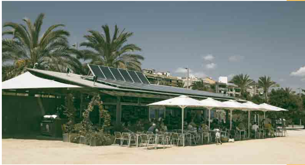
Instal·lació fotovoltaica del restaurant Lasal del Varador (Mataró), pionera a Europa a demostrar que l'autoconsum instantani és viable econòmicament (amb la legislació vigent en el moment de la instal·lació). Produeix més de 12.500 kWh/any (quatre vegades el consum elèctric mitjà d'una llar amb 4 persones), estalvia unes 8 tones de CO 2 l'any, i es preveu amortitzar-la en 7'5 anys. Foto: Stella Rotger.
